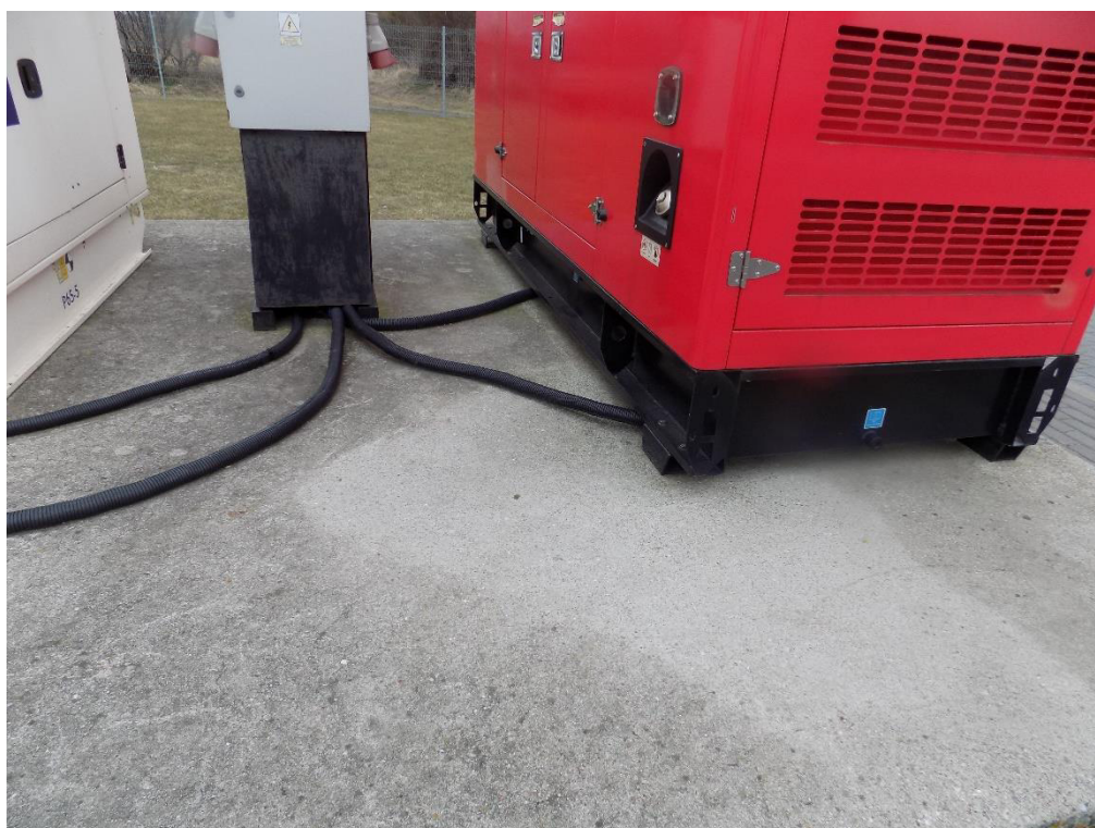
Brak ochrony odgromowej agregatów prądotwórczych (Rzut terenu – odnośnik Pkt 2)
